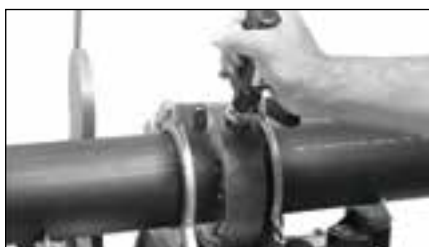
Srovnání konců potrubí integr. hoblíkem
