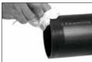
Ošetření konců potrubí PE čisticím přípravkem
