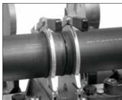
Chladnutí svařeného spoje
