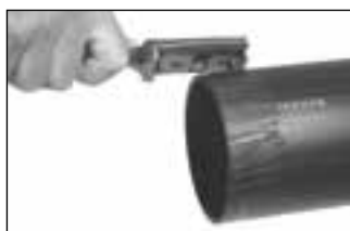
Oškrabání konců potrubí ruční škrabkou
