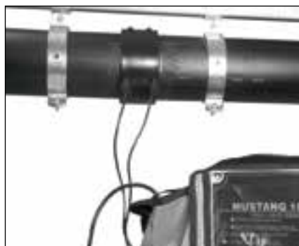
Svařování pomocí elektrodoporového nátrubku
