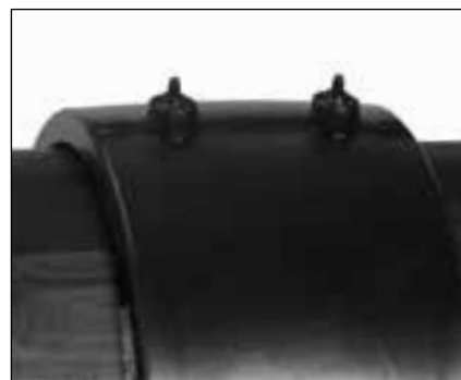
Detail správně vytvořeného spoje (oba indikátory tvarovky jsou vysunuty)
