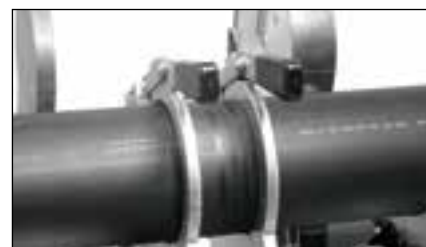
Správně připravené potrubí ke svařování
