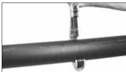
Řez potrubí ruční rotační řezačkou
