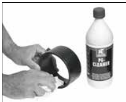
Ošetření vnitřního povrchu elektrotvarovky PE čisticím přípravkem
